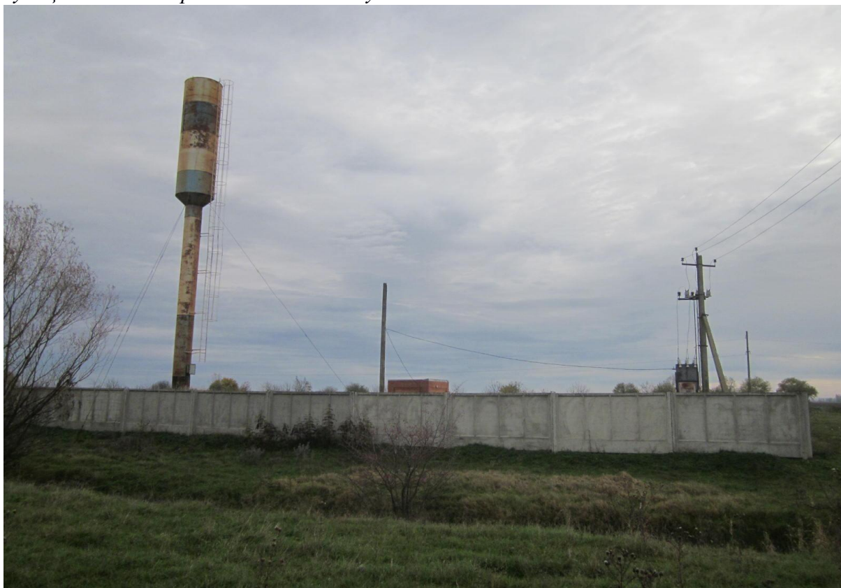
Водонапорная башня. а.Хатажукай. Не покрашена.
