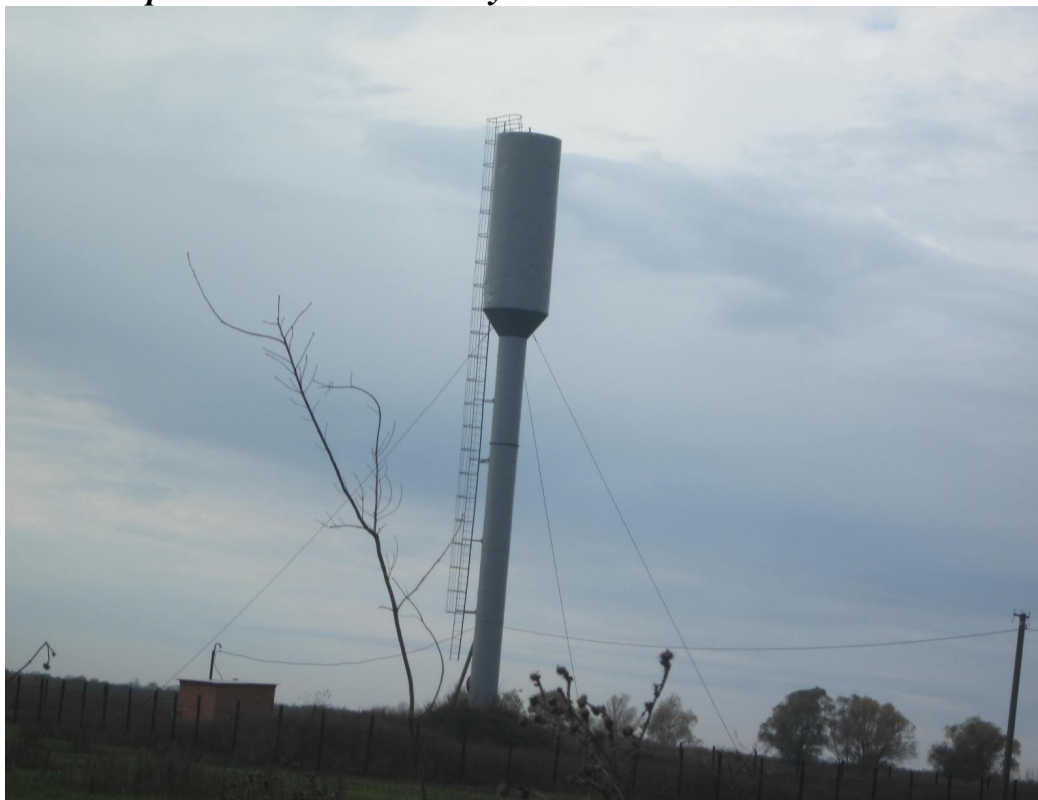
а.Пиизов. Водонапорная башня. Новая.
