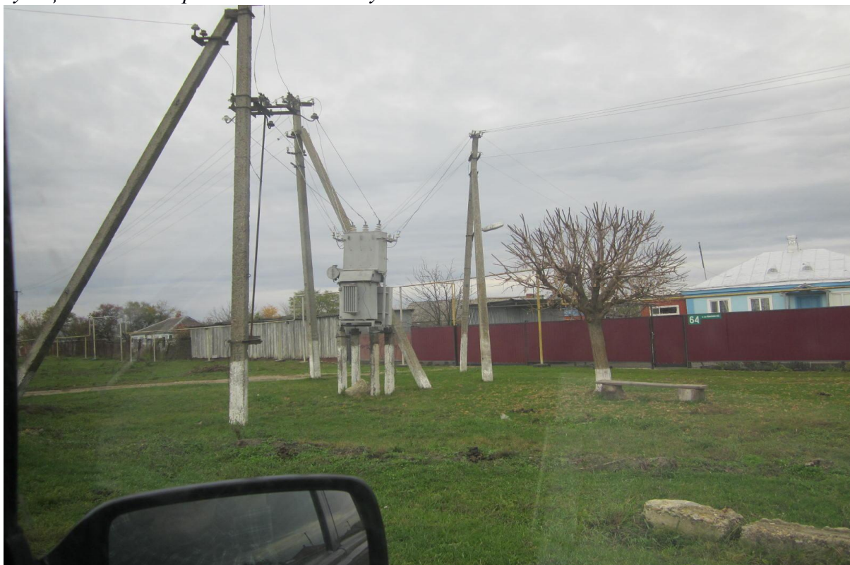
Трансформаторная подстанция-100 кВт. ул.Пушизова. Нет надписей. Стоит под углом 3°.
