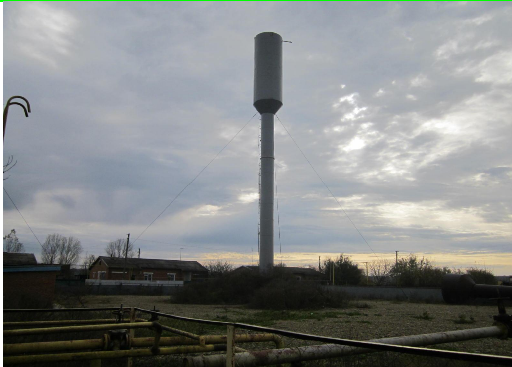
Водонапорная башня ШУОС. Аул Пиизов
