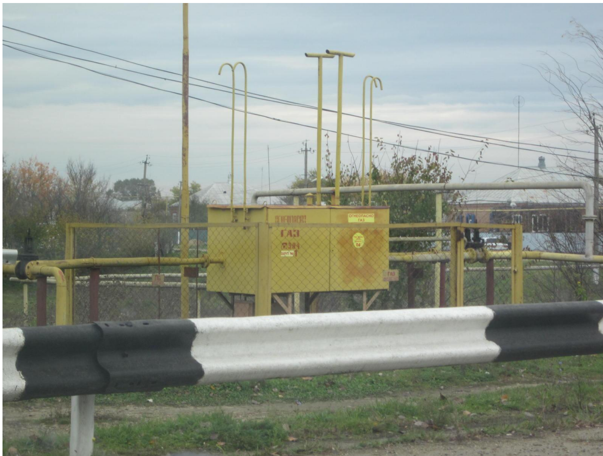
ГРПШ. а.Кабехабль. ул.Ленина. Задвижка ржавая.
