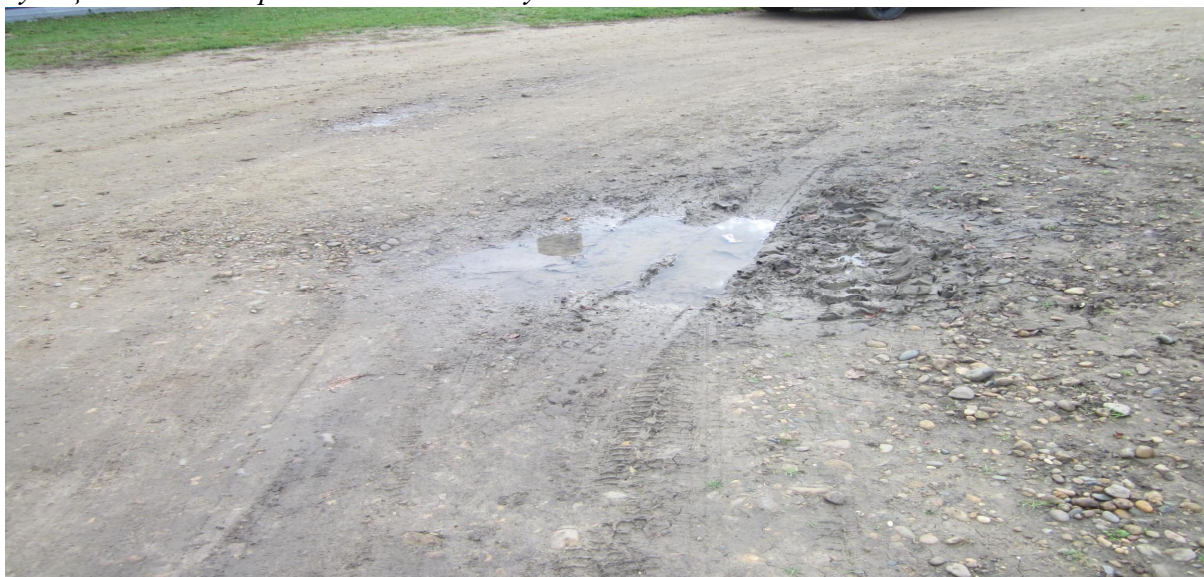
Водоотведение. ул.Заречная. а.Пиизов.
